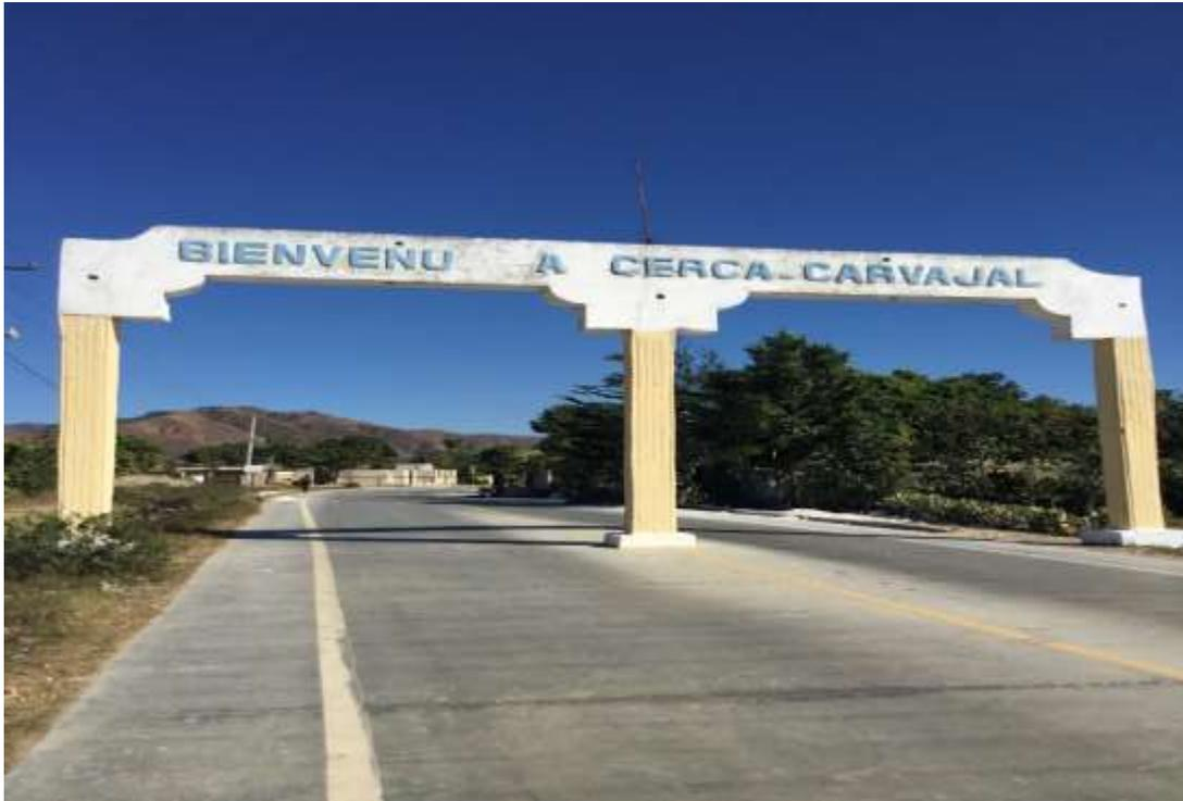
Couche de surface en béton armé c35 (0,22m d'épaisseur) rayure de gavage au pk5+000 au pk s6+000\*7m, du pk11+000 au pk13+000\*3,5m.
