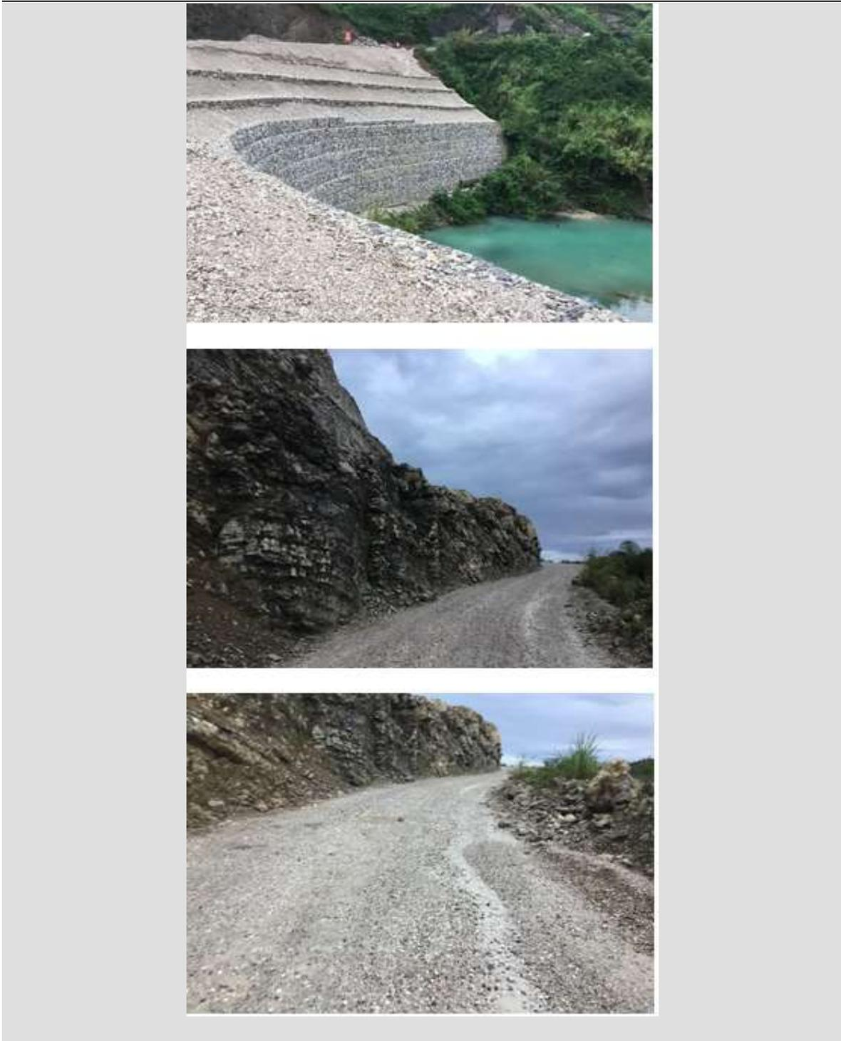
Photos : 1, 2 et 3 : Ouvrage de consolidation d'un passage étroit et zone à dynamiter pour élargir la voie
