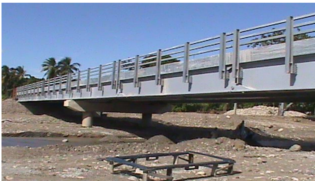
Pont construit sur la Rivière Moncel
