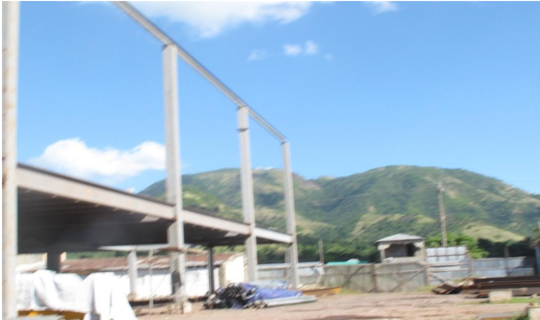
Marché public de Grande Rivière du Nord en construction
