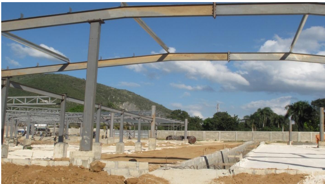
Le Marché public de Pignon en construction
