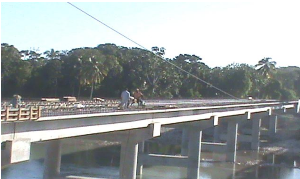
Un des nouveaux ponts construits dans la zone de Jérémie
